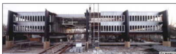
Varsovie : Ambassade France en rénovation
